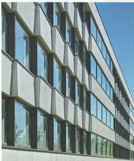
Bild 2. Durch den cleveren Einsatz von ca. 15.000 m 2 Doppelwand und 14.000 m 2 Elementdecke konnten die MEIER Betonwerke GmbH die geplante Bauzeit erheblich verkürzen
