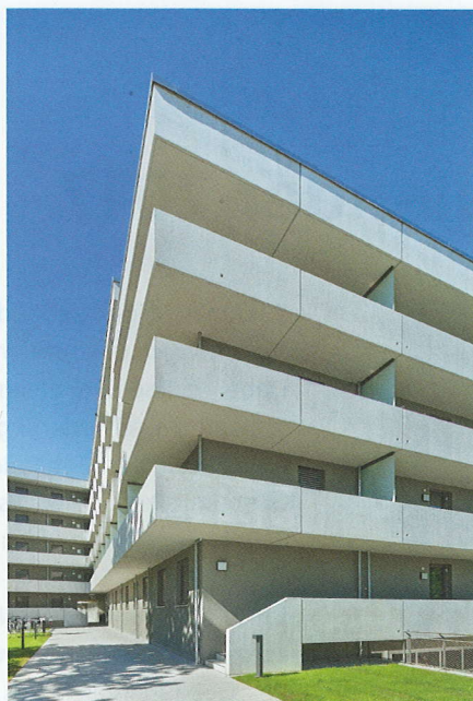
Bild 2. Durch den cleveren Einsatz von ca. 15.000 m 2 Doppelwand und 14.000 m 2 Elementdecke konnten die MEIER Betonwerke GmbH die geplante Bauzeit erheblich verkürzen
